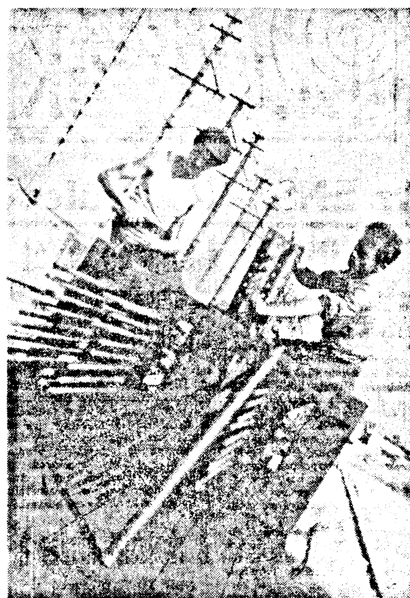
Az Építélemgyárból immár nagy sorozatban gyártják az előre feszített betonoszlopokat. Felvételünk a betonban lévő vasak feszítő szerkezetéről és annak kezelőiről készült.
