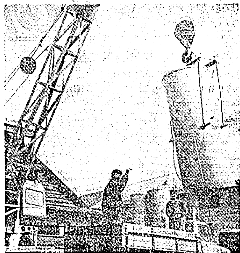
Un nou lot de produse al Uzinei de reparatii arădene sînt încărcate pentru a lua drumul gospodăriilor agricole de stat şi a cooperativelor agricole de producţie.
