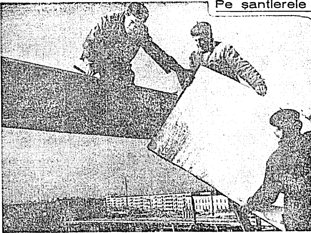
Pe șantierul cvartalului de locuințe Podgoria, se lucrează intens. De data aceasta obiectivul fotografic a surprins pe tovarășii Mihai Varga, Ioan Vezir și Ioan Kocsis, utemiști, montând table pe cupola blocului G.
