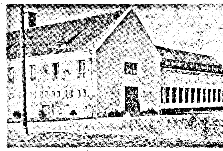
A népi demokrácia évelében épült a kármesei mo- dern kénygyár. Itt az összes munkálatokat gépesítették. A legjobb munkakörülményeket biztosították az itt dolgo- zók számára. Képünkön a kármesei kénygyár új épülete
