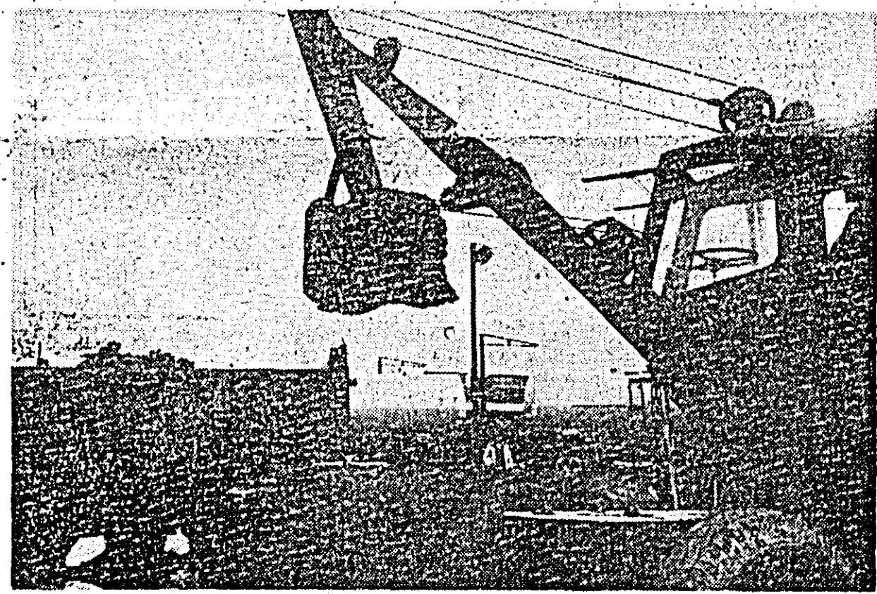
În cadrul sectorului I al Uzinelor de vagoane se va construi un nou turn de apă care va îmbunătăți aprovizionarea cu apă a sectorului. Fotografia noastră reprezintă un aspect din timpul săpăturilor pentru fundație. După cum se vede săpăturile se fac mecanizat.
