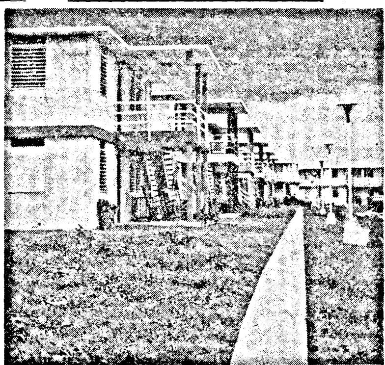
Ujonnan épült lakások egy kubai állami gazdaság dolgozói számára
