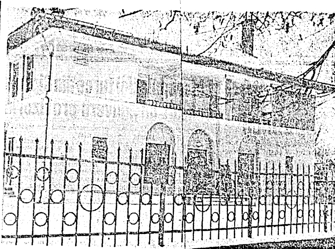
Această clădire impozantă în inima comunei Dorji, nu există în urmă cu cîțiva ani. Astăzi locuitorii săi se mîndresc cu frumusețea lor căminară.
