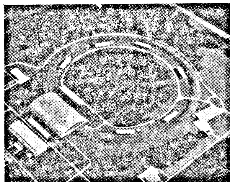
A Szovjetunióban Serpukhovo város közelében épül a világ legnagyobb részecskegyorsítója a 70 milliárd elektronvoltos proton szinkrotronja. Képünkön az egyedülálló új berendezés makettje. A szinkrotron-gyűrűjének átmérője 472 méter.
