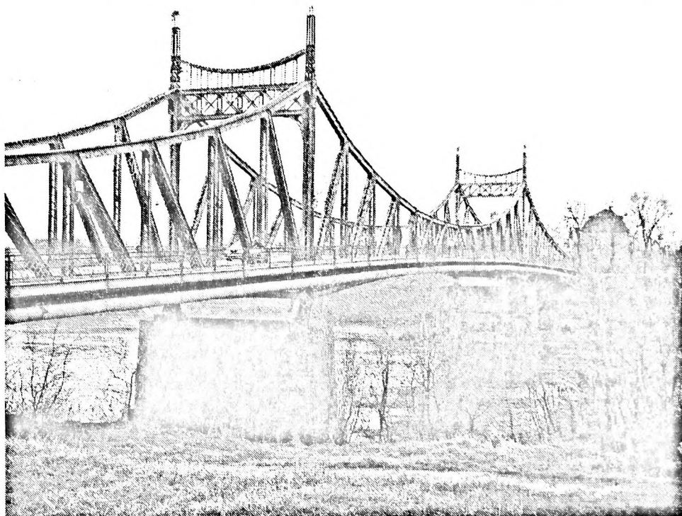
Podul înainte de restaurare
