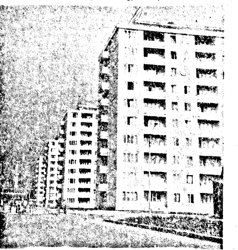
Elkészült Vajdahygyad első toronyblokk sora.
