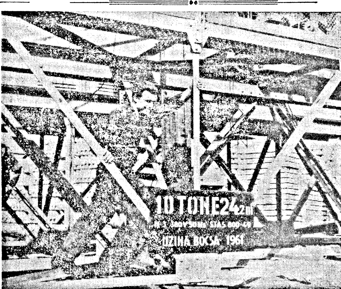
CSEHSZLOVÁK SZOCIALISTA KÖZTARSASAG. A román NK-ban készült görög hídakat kapnak a csehszlovák üzemek. Egy ilyen nagy teljesítményű görög híd szerelnek a Prefa üzemben. Képünkön a görög híd szerelését láthatjuk.
