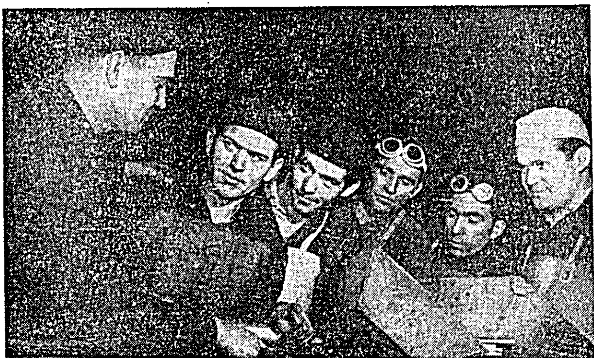
Echipa tovarășului Mircea Pană din secția pregătire I a Uzinelor de vagoane, execută lungoronele vagonului GVAS. Este una din echipele care și-a realizat printre primele din secție planul anual.
