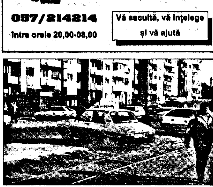
În apropierea stației de tramvai Fortuna, exemplu clasic de lucru făcut de mântulăia (șanțul „uitat” între liniile de tramvai)
