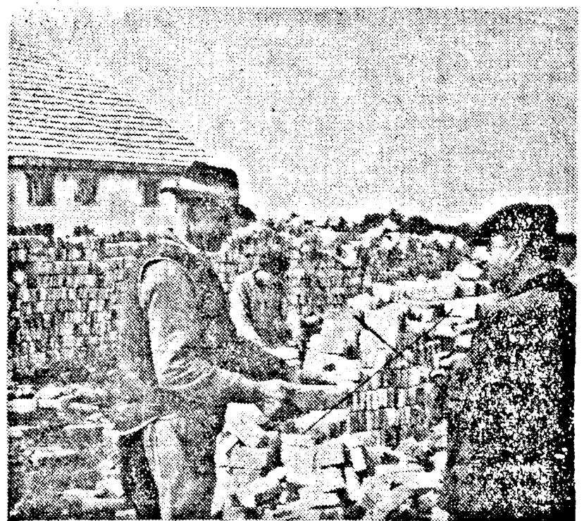
Ide építjük az új tehénistállót.
