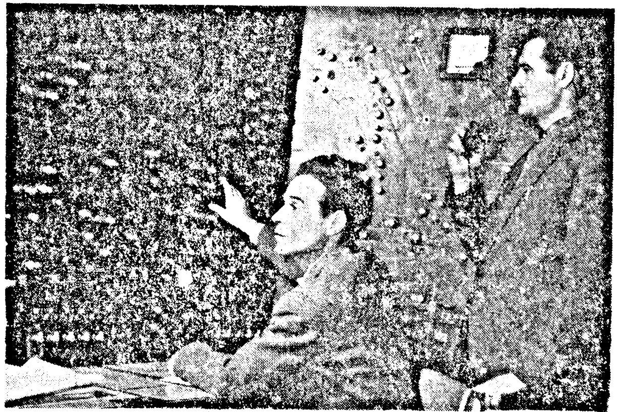
Felvételünk az aradi vasúti állomás forgalmi osztályán készült. Vasilescu Petru forgalmazta hozzá- értéssel kezelő a pályaudvar forgalmát irányító automata berendezést, miközben a fényjelzéses mű- szertáblán figyelemmel kíséri utbalgazatásának teljesítését. A háttérben: Mocuta Petru elektromechani- kus, a kompakt automatá berendezés egyik szakavatott karbantartója. (Kelen Ferenc felvétele)
