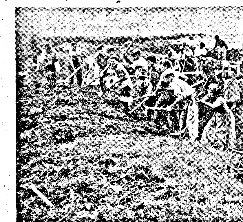
Az ötvenes állami gazdaság dolgozói lelkesen vesznek részt a csatornázási munkákban. Tudják, hogy a csatorna számukra is nagy előnyököt jelent majd.
