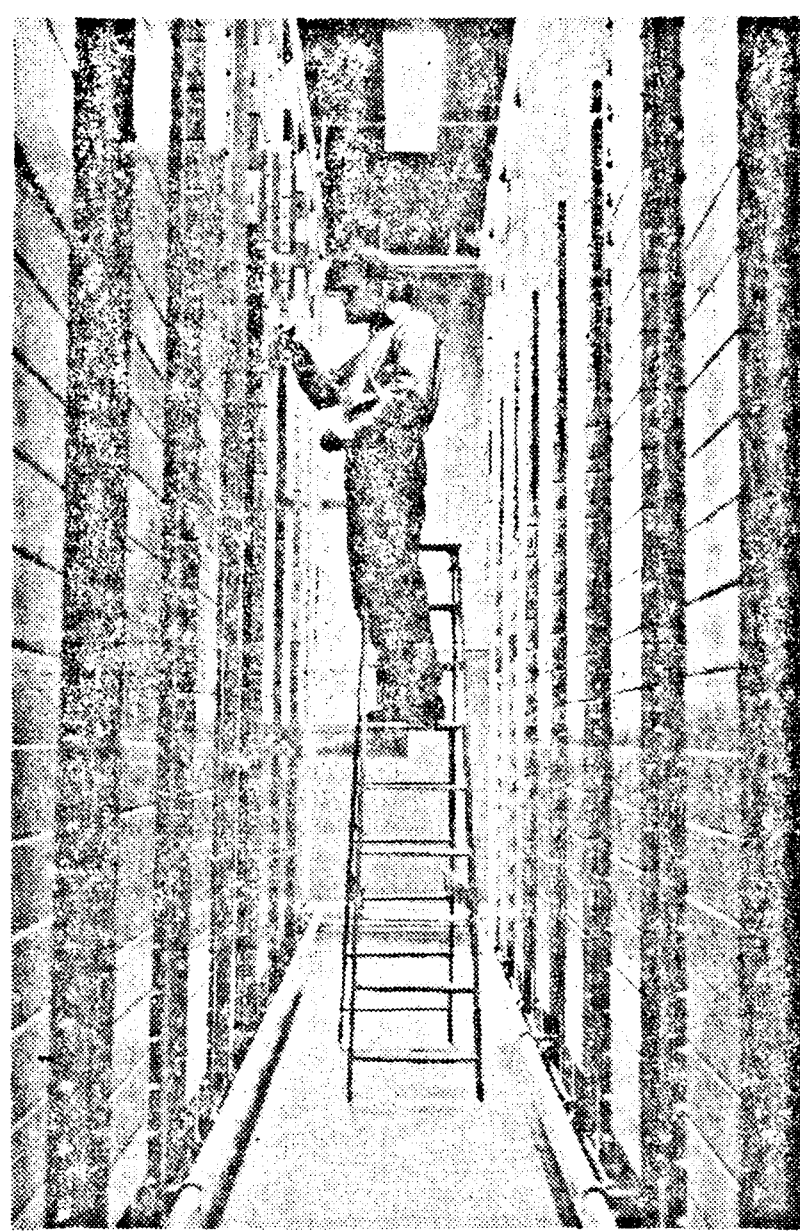
A telefonközpont ügyeleti elektrotechnika ellenőri a szerkezeteket. (KELEN FERENC felvétele)
