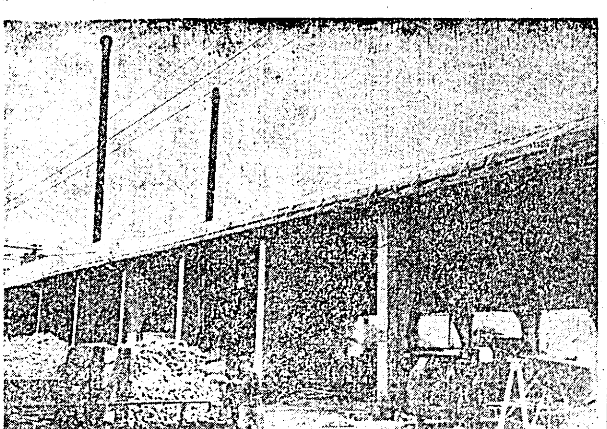
Noua hală a gaterelor aflată în construcție.
